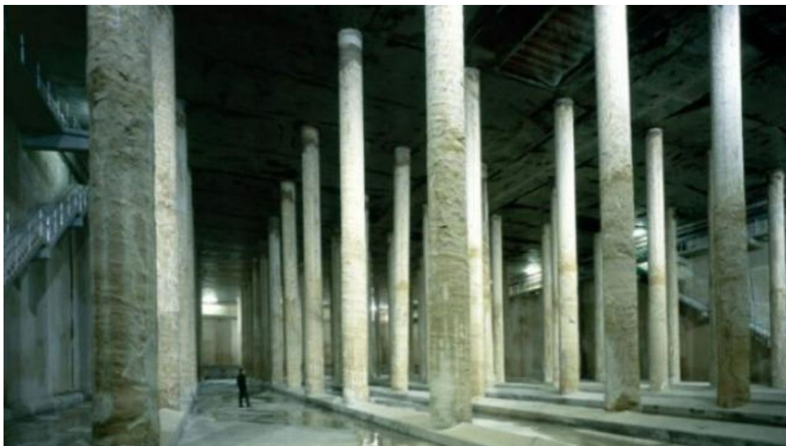
Depósito para la recogida de aguas pluviales y freáticas en Barcelona. / Ayuntamiento de Barcelona
