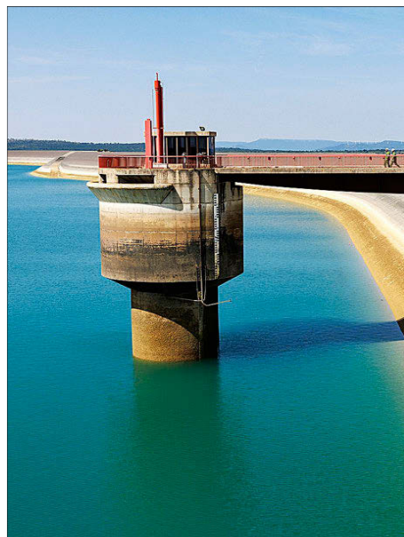
Detalle del embalse de Cortes-La Muela, en Cortes de Pallás.
